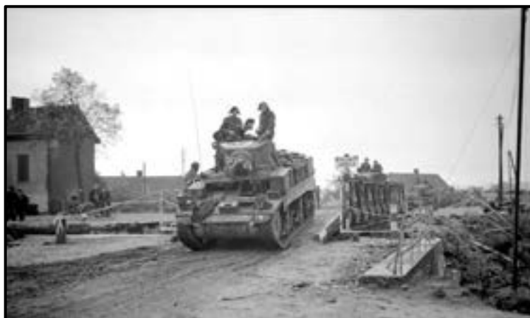
Links leggen Britse Royal Engineers van de 49 ste Divisie een Baileybrug over het kanaal van Turnhout. Rechts passeert een Stuart tank bij Rijkevorsel Plum-bridge 1 op 22 oktober 1944
