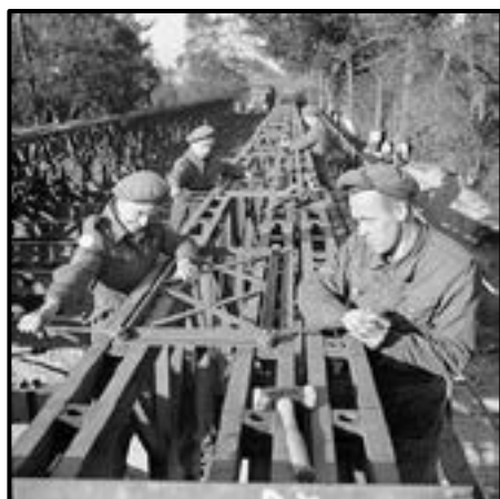
Links leggen Britse Royal Engineers van de 49 ste Divisie een Baileybrug over het kanaal van Turnhout. Rechts passeert een Stuart tank bij Rijkevorsel Plum-bridge 1 op 22 oktober 1944
